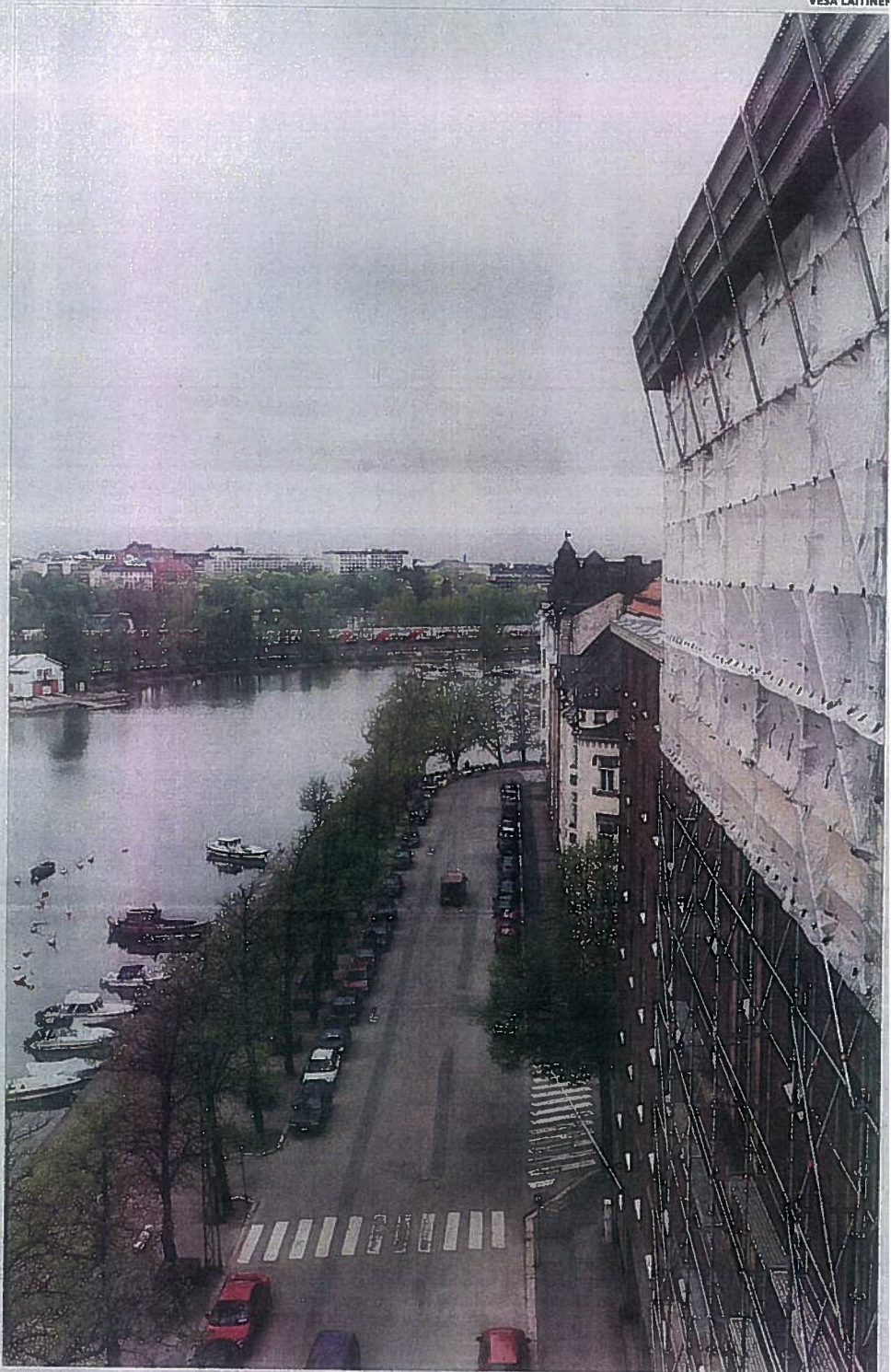
Pitkäsillanrannan ullakkotyömaalta avautuvat upeat näkymät Kaisaniemeen ja Töölöön.
